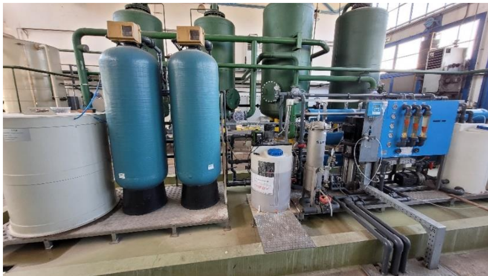
4. ábra: Vízlágyító berendezés (balra) és fordított ozmózis berendezés (jobbra), háttérben a zöld ioncserélő oszlopok
