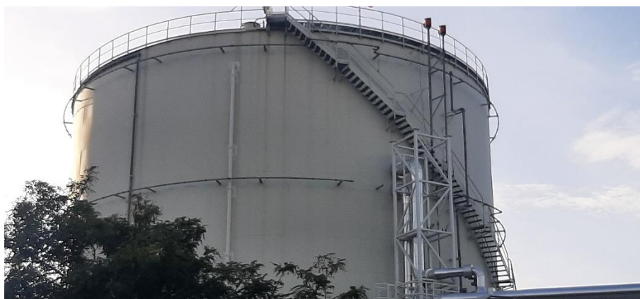
18. ábra. Csatlakozó felső vízvezeték a hőtárolónál
