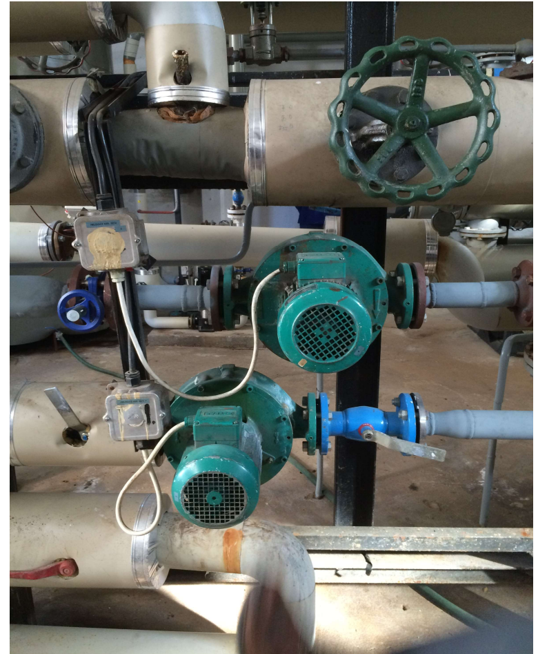
Kép: régi, egyfokozatú HMV szivattyú
