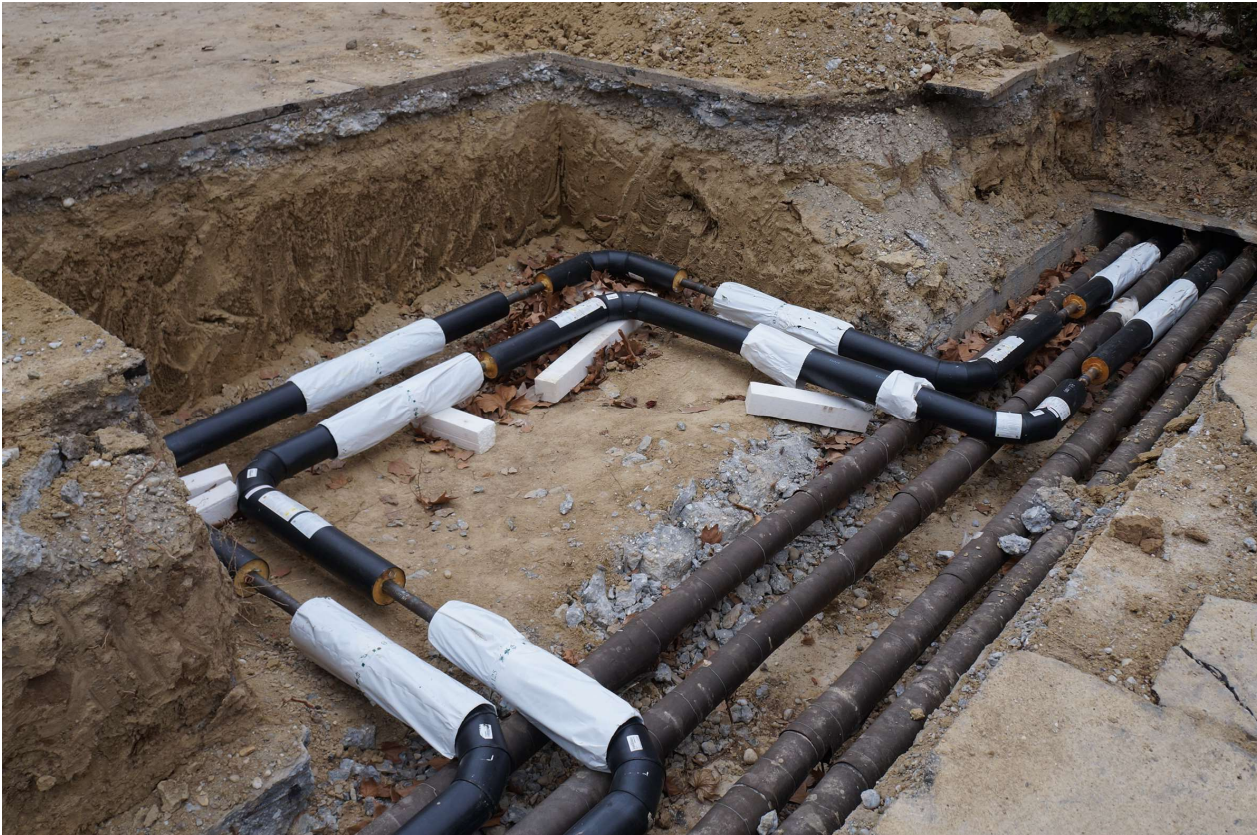
Kép: szekunder vezeték kiváltása új primer vezetékkel
