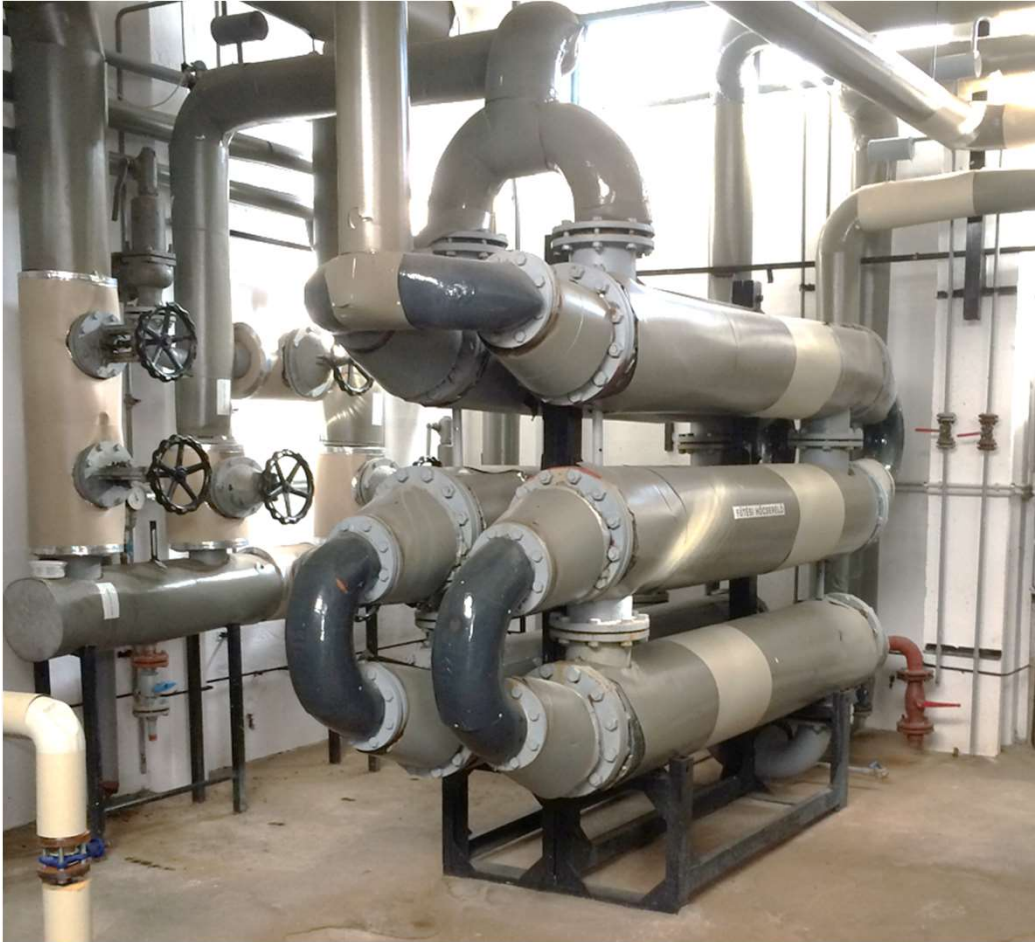
Kép: rossz hatásfokú építőelemes hőcserélő
