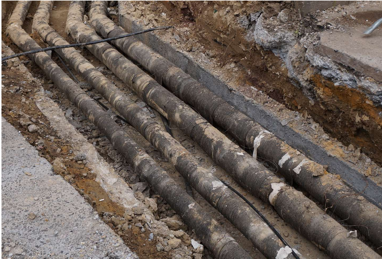
Kép: hagyományos hőszigetelésű szekunder vezeték védőcsatornában
