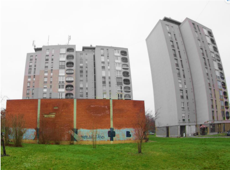
Szolgáltatói hőközpont (több épületet lát el) 94 db
