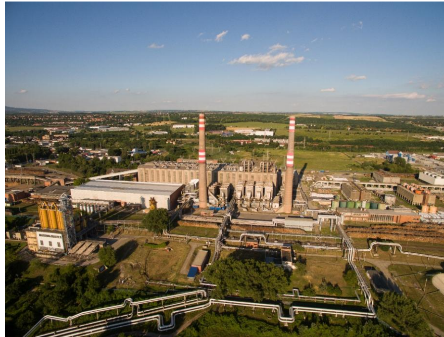
Pannon Hőerőmű Zrt. Kapcsolt hő- és áramtermelés
