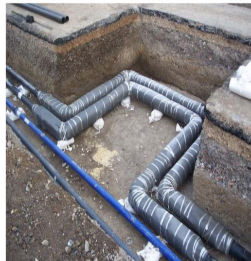
Közvetlenül földbe fektetett előszigetelt 34 km
