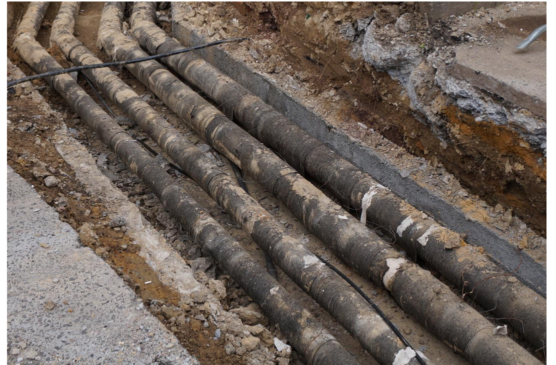
Kép: négyvezetékes elavult szekunder hálózat
