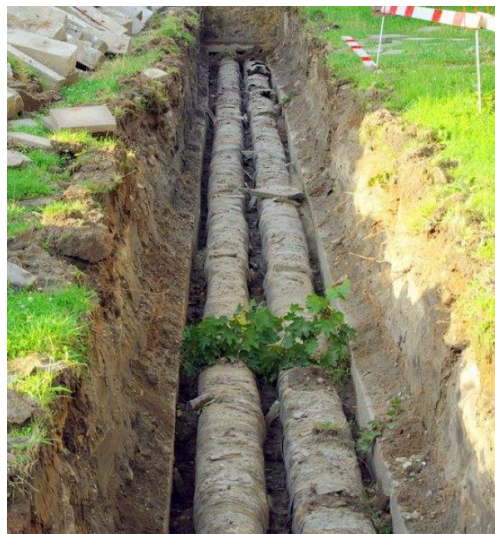
Vasbeton védőcsatornában 58 km
