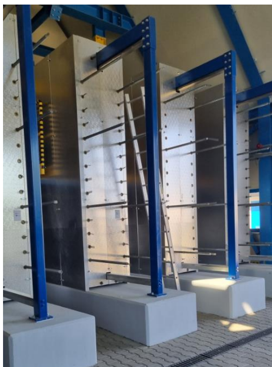
10. kép: Lemezes hőcserélők Szaflary településen
