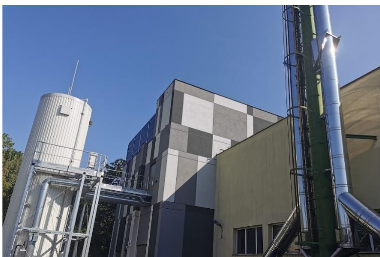
7. kép: A korábbi fűtőmű épülete (sárga) és a meglévő gázkazánok kéményei, illetve a gázmotorok épülete (szürke), valamint a kapcsolódó hőtárolók
