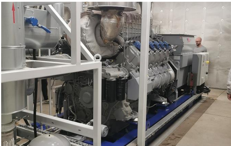
8. kép: ~1 MW névleges teljesítményű MTU gázmotor
