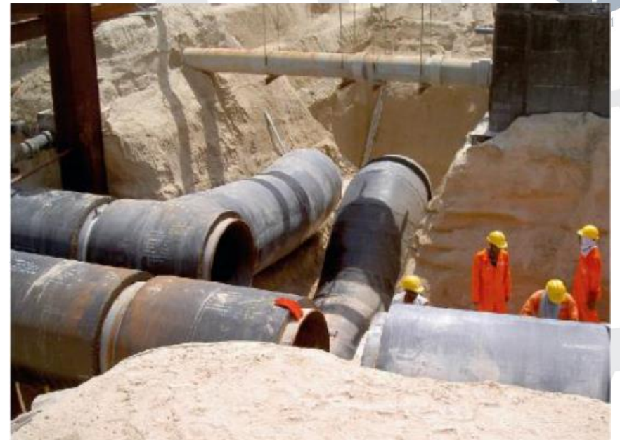
Távhűtési elosztóhálózat telepítése Dubaiban
