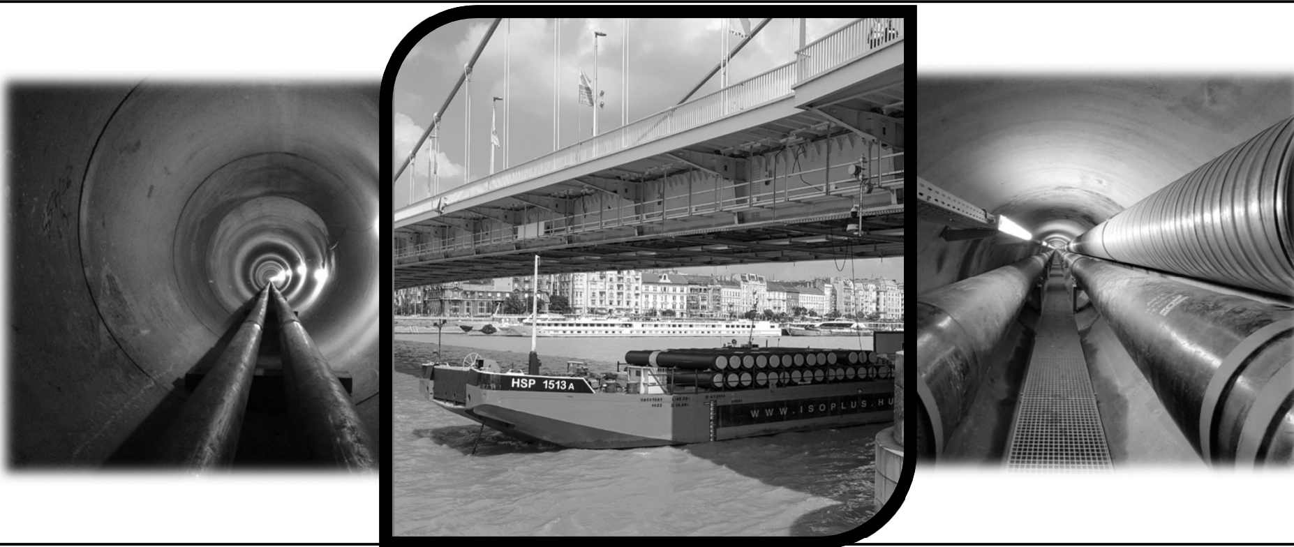
Budapest Hungary Erzsébet Bridge&Tunnel 2018-2019 2xDN 250- DN600
