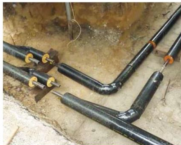
Felhasználói hőközponthoz kiépített előszigetelt, közvetlenül földre fektetett primer vezeték
