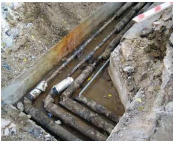
Szolgáltatói hőközpont gyenge hőszigetelésű, nagy hőveszteségű szekunder vezeték
