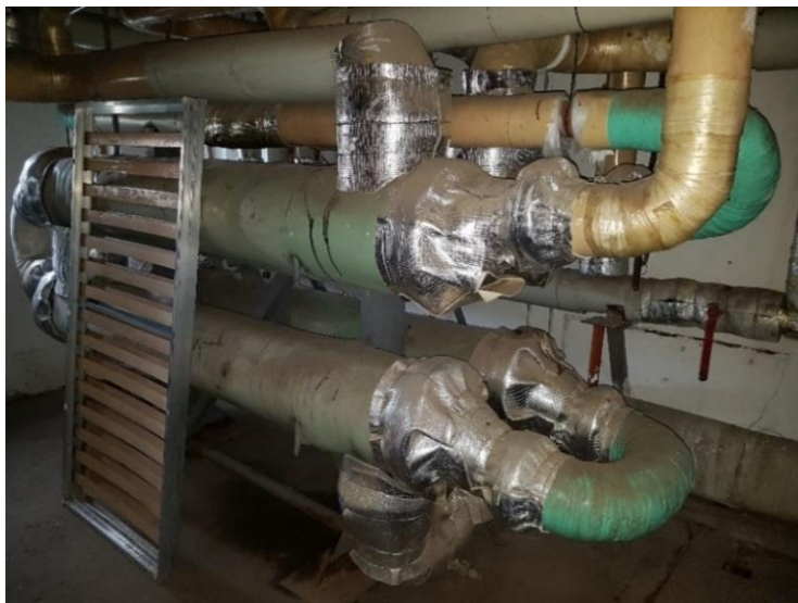
1. ábra: Szobaméretű csőköteges hőcserélő egy komáromi hőközpontban
