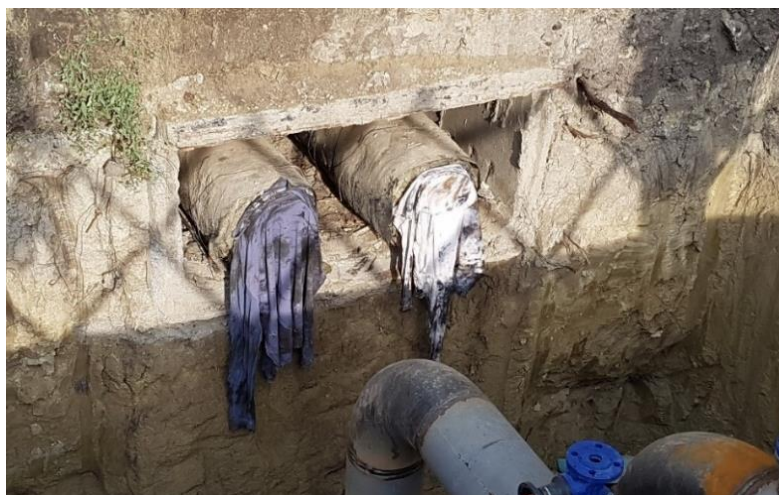
2. ábra: Szakaszkiváltáskor megbontott régi, betoncsőben vezetett távvezeték
