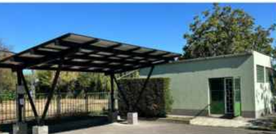
Kertvárosi Fűtőmű - Telepítés éve: 2026, Teljesítmény: 8 kw
