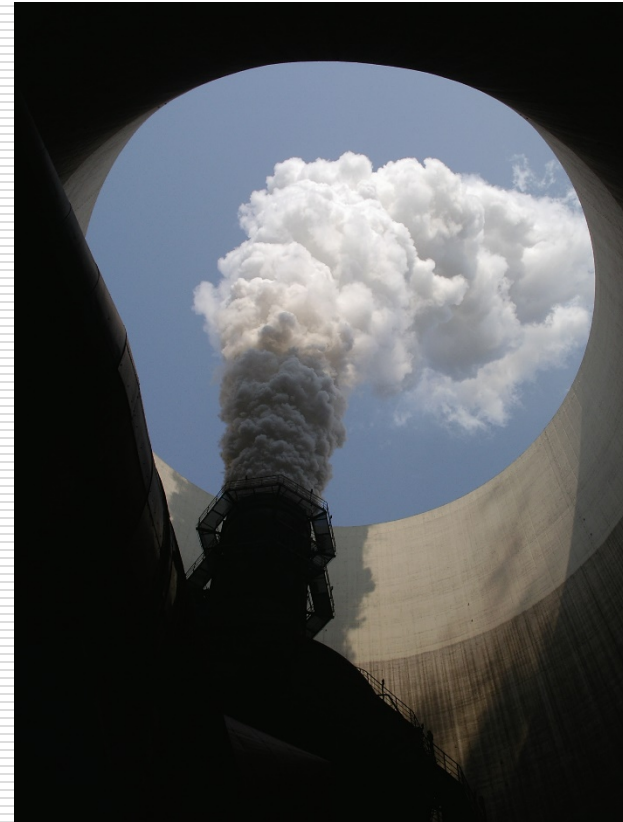
Hűtőtorony, közepén a kéntelenítő kéményével
